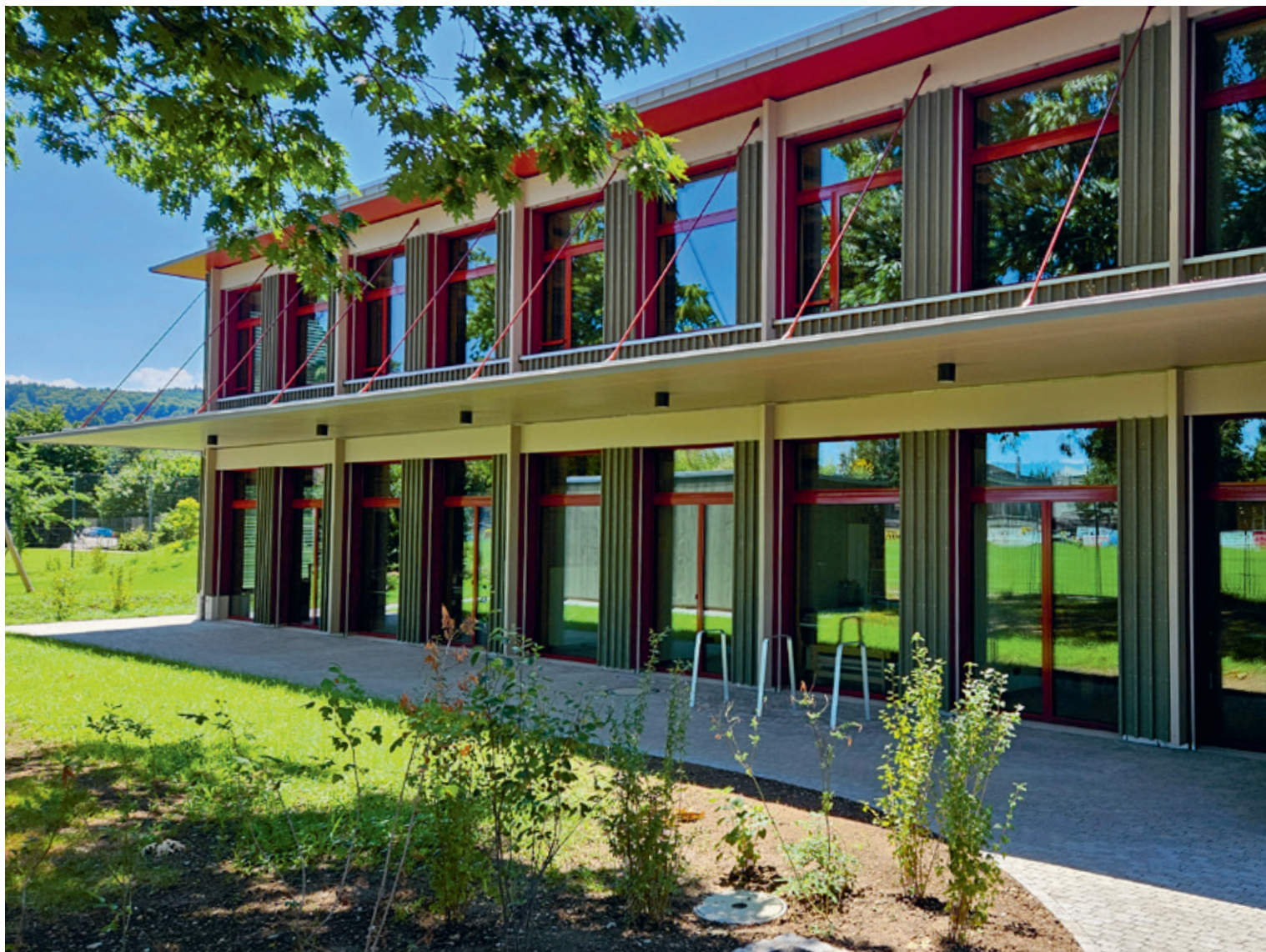
Das zweigeschossige Schulhaus Nord in Bischofszell ist für weitere zwei Geschosse gut vorbereitet.
