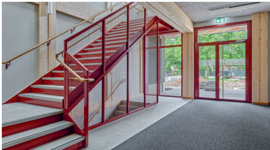
Ein markantes Bauteil im Holzgebäude ist die rote Stahltreppe.
